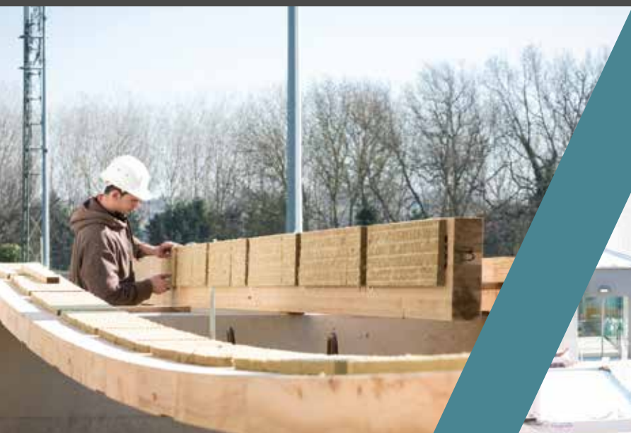
ICF Atlantique logements collectifs Smart city à Toulouse
